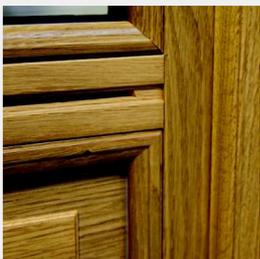
Détail moulure du sous-bassement, chêne massif
